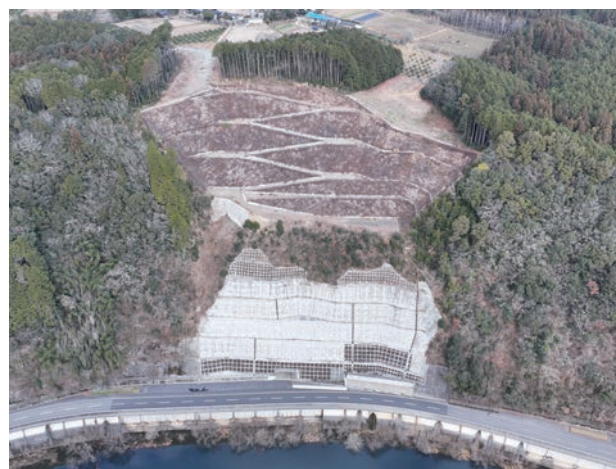
復旧工事完了
