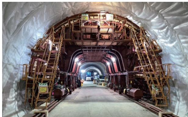
セントル覆工打設状況
