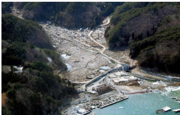
漁港背後集落の被害状況
