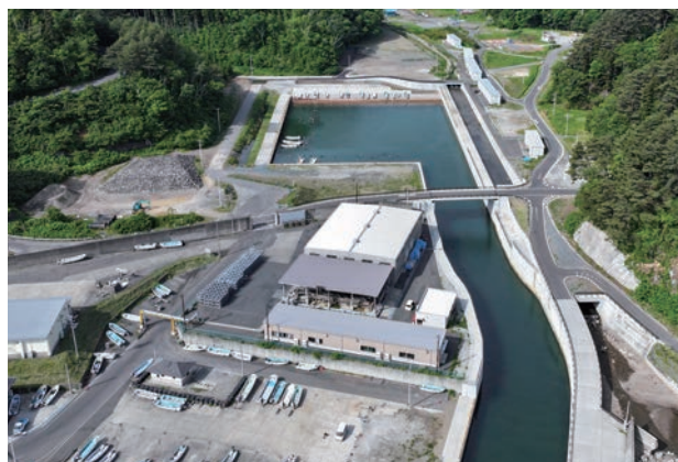
完成した掘込式漁港
