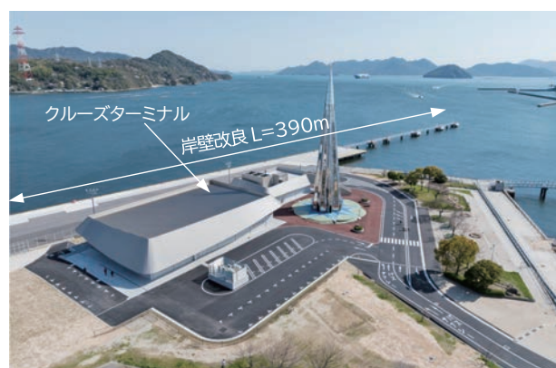
広島港クルーズターミナル全景
