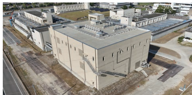
オゾンAOP施設 外観
