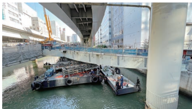
潮位の変動を利用した桁撤去
