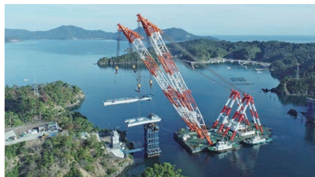
側径間の2ブロック同時架設
