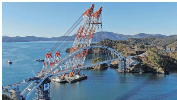
起重機船「海翔」による中央径間の架設
