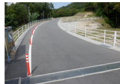
避難路の整備
