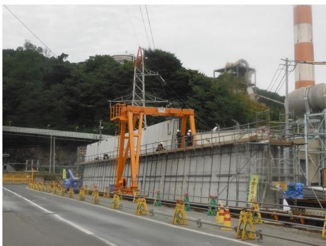
高圧線直下の防潮堤は、現場打と門型クレーン架設によるプレキャスト防潮堤への組み合わせの工法を採用した
