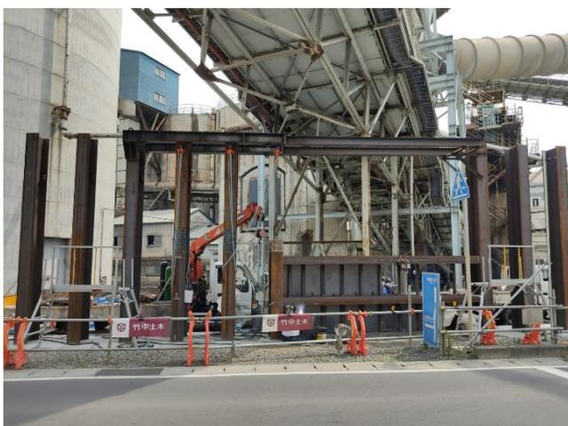
老朽化のため移設不可の工場施設を避ける工法に変更。ミリ単位の精度が求められ、極めて困難な施工となった
