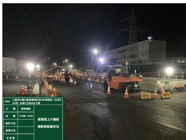
交通量の多い市道を最大1.2m嵩上げる必要があったが、一般交通を確保しながら、わずか9日間の夜間急速施工で完了させた
