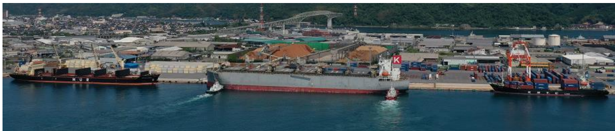
写真-2 本事業で整備した施設での荷役の状況
