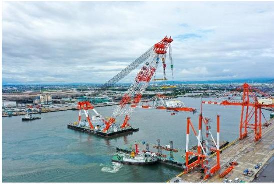
新設ガントリークレーンの据付は、大型の海上クレーンで上下を合体
