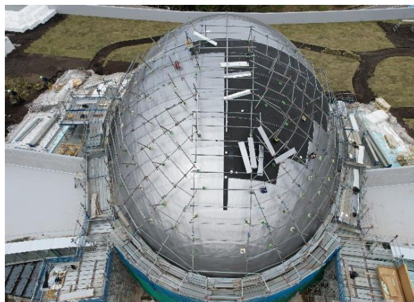
小タマゴ屋根施工状況
