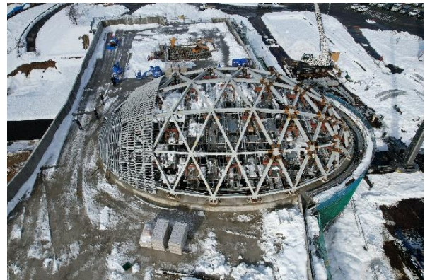
小タマゴ鉄骨建方
