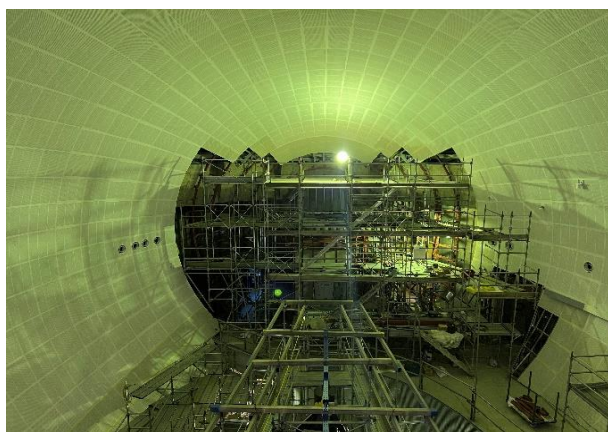
内装ボード張付状況
