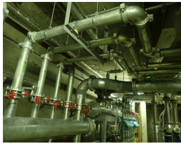
施工後:配管敷設状況(天井付近) ※ 配管の整理状況
