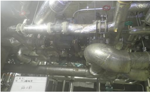
施工前:配管敷設状況(天井付近)
