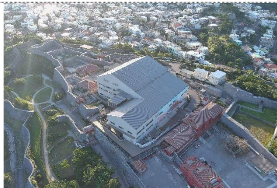
復元中の首里城の様子(令和5年11月1日撮影)
