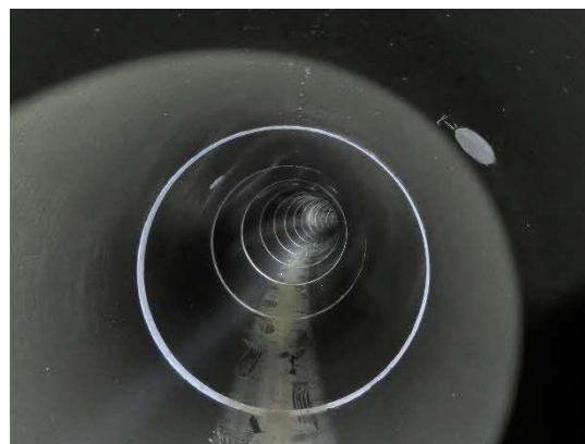
下水道幹線管渠 写真
