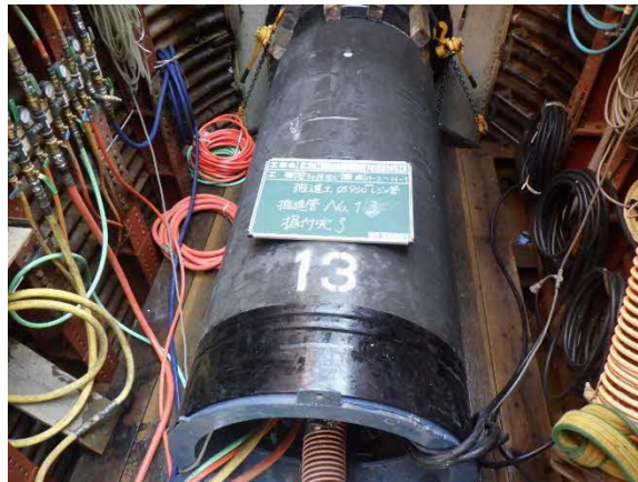
管渠推進工法 施工状況
