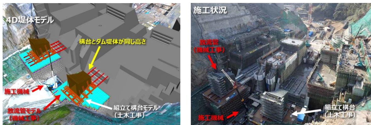
■上段常用洪水吐放流管横引施工
