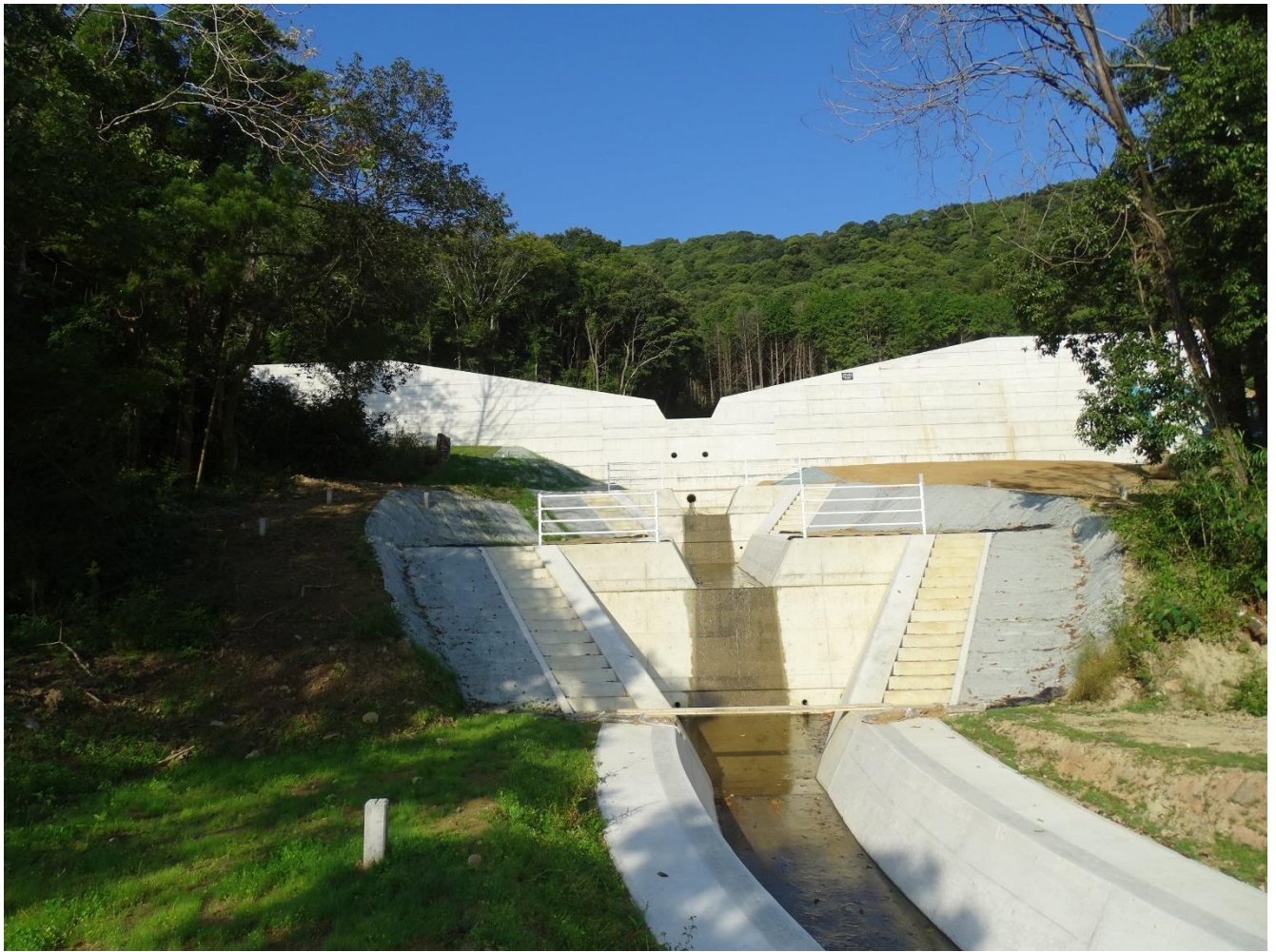
砂防堰堤完成時
