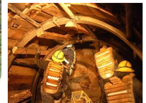
写真-7 送り矢板工法
