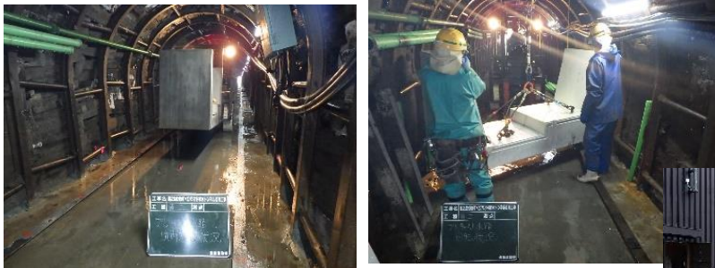
写真-10 覆工PC設置状況及び索道受け渡し状況
