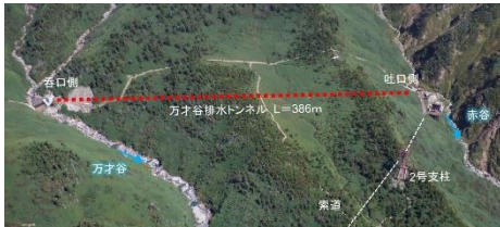
写真-3 万才谷排水トンネル経路
