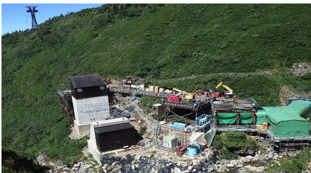
写真-8 吐口側の施工状況【狭隘な施工ヤード】
