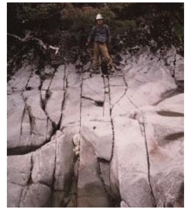
写真-2 万才谷の河床亀裂
