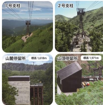
写真-5 索道設備
