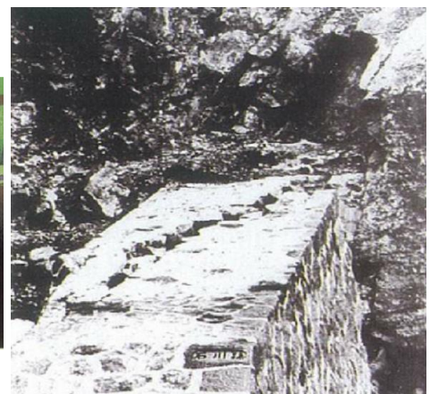
写真-1 甚之助谷第5号砂防堰堤の亀裂
