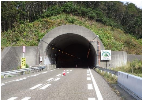
写真-1 米山トンネル(下り線) 坑口写真
