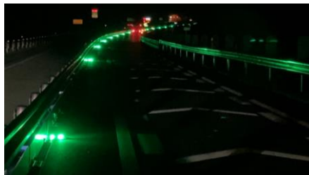
写真-6 路面誘導灯設置状況
