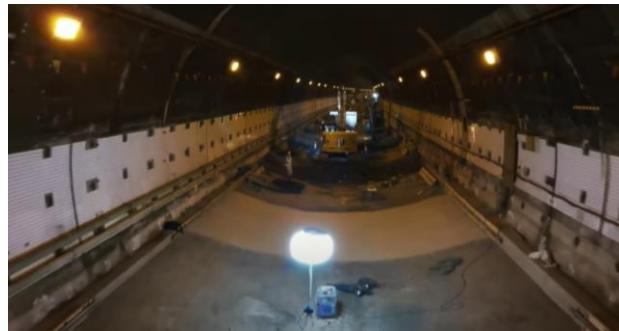
写真-2 トンネルインバート施工中写真
