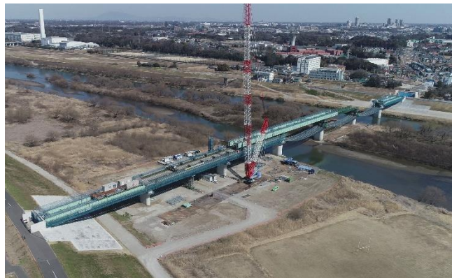
送り出し工法
