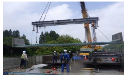
写真2 壁高欄施工済みのPC床版架設状況写真
