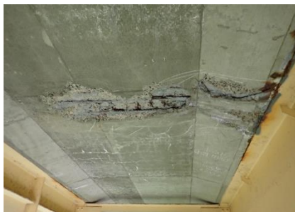
浮き・剥落 床版取替前の損傷状況
