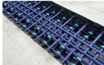
写真1 合理化継手(MuSSL 工法)の施工写真
