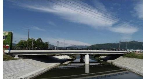
【プレビーム工法[鋼とコンクリートの複合構造]の採用により桁高が低くできたことで防災を始め各種課題が解決】
