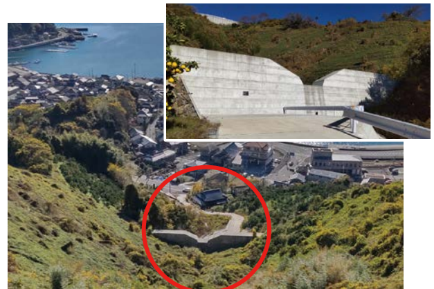
完成した砂防堰堤と保全集落
