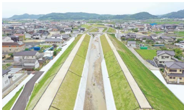
完成した末政川堤防
