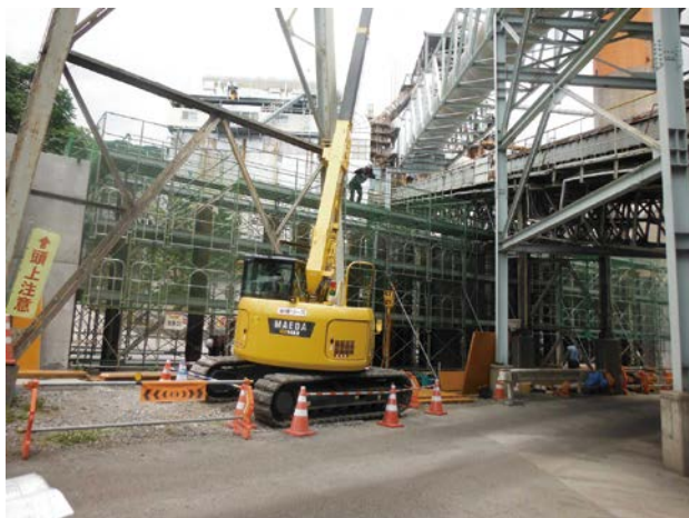
上空占有物件下での防潮堤施工
