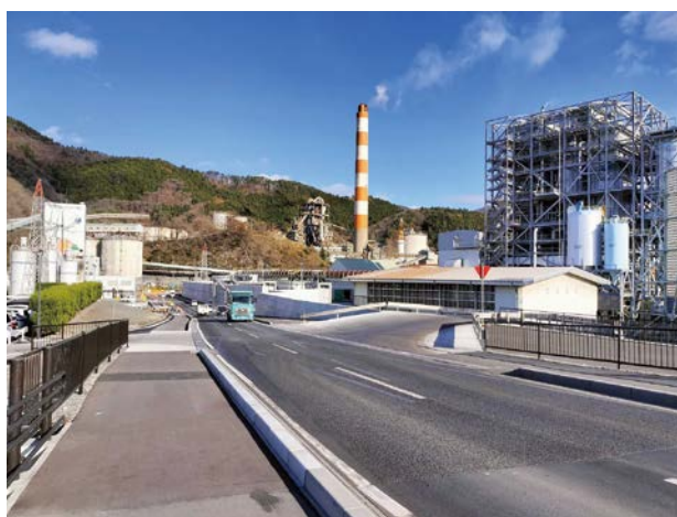
完成した防潮堤と隣接する工場
