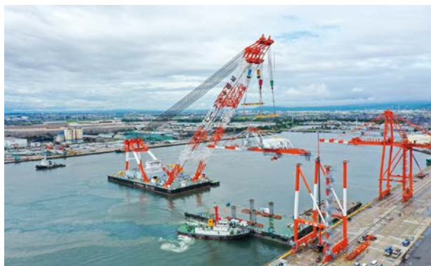
新設ガントリークレーンは大型海上クレーンで上下合体
