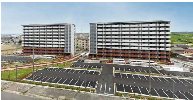
PFI手法を用い建替えた県営住宅
