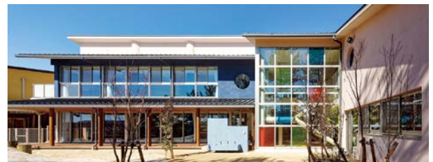
活用用地に建設された保育所
