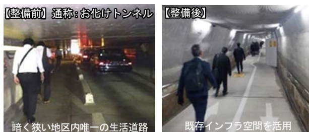
仮設歩通路整備前後の状況
