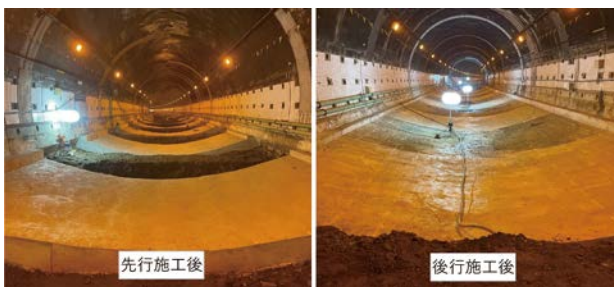
インバート設置状況
