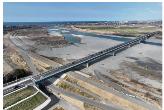
川北能美大橋（橋長L=537.3m）
