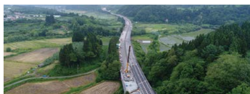
3橋連続施工現場状況写真
