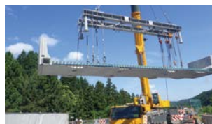
フルキャスト壁高欄の設置
