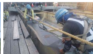
重防食シートの施工
