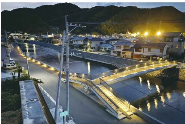
特殊堤や高欄にLED照明を設置
