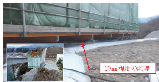
移動作業車による架設状況
