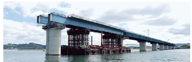
台船一括架設の現地施工写真
