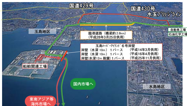
事業対象箇所及び周辺港湾施設
