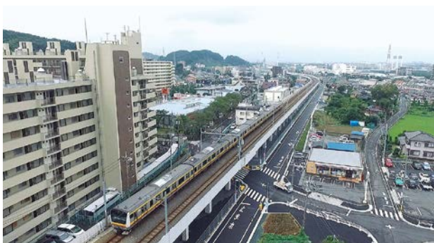
完了状況（稲城長沼駅～南多摩駅間）
