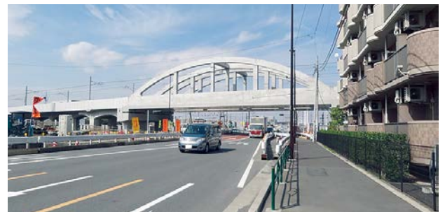
多摩3・3・7号線（旧谷戸川踏切部）
