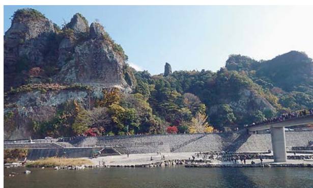
完成した青地区堤防
