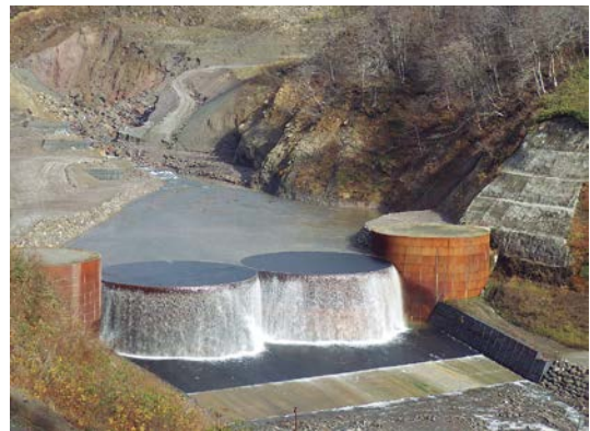
完成した湯浜砂防堰堤
