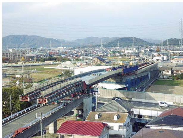
上部架設状況
