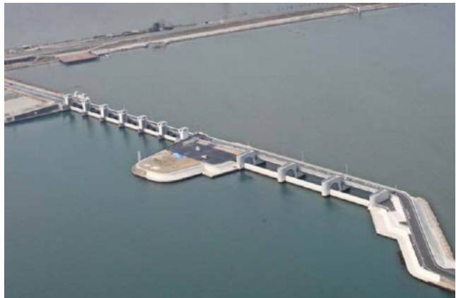
完成した百間川河口水門
