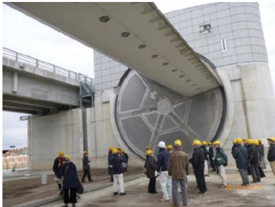
全開した状態のライジングセクターゲート
