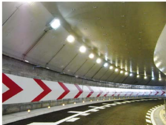
シールド区間完成状況
