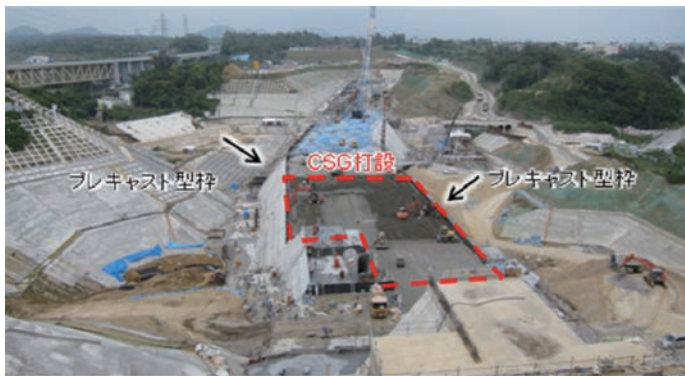
ダム本体（台形CSGダム形式）施工状況
