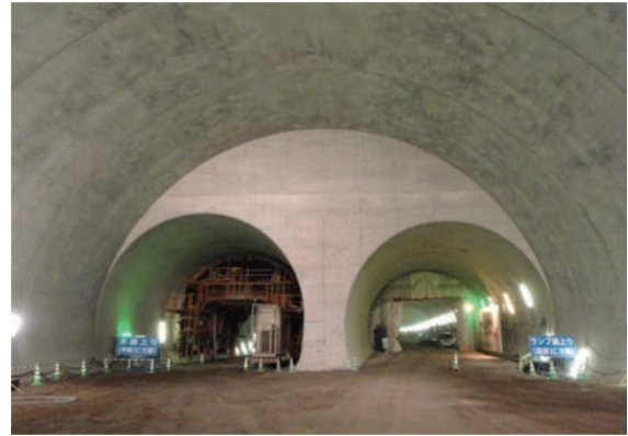
覆土完了 シラス地山中に2車線断面を左右2本設置
