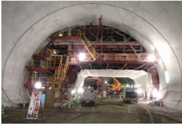
超大断面施工 地中分岐を周辺環境に影響を与えずに施工
