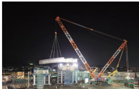
阪急京都線上空架設状況
