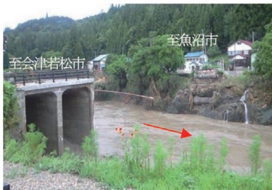
落橋後の状況
