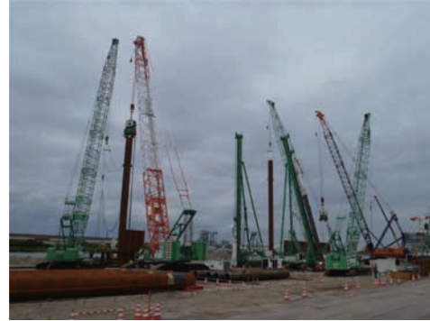
岸壁鋼矢板等打ち込み状況
