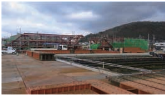
製作ヤードでの組立作業
