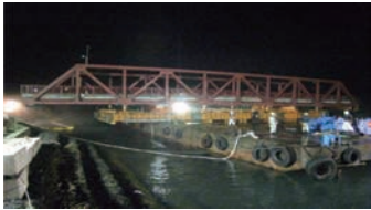
台船による一括架設状況
