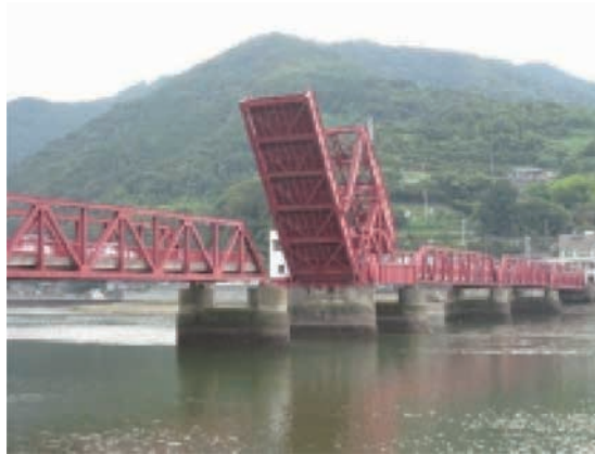
長浜大橋（開閉状況）
