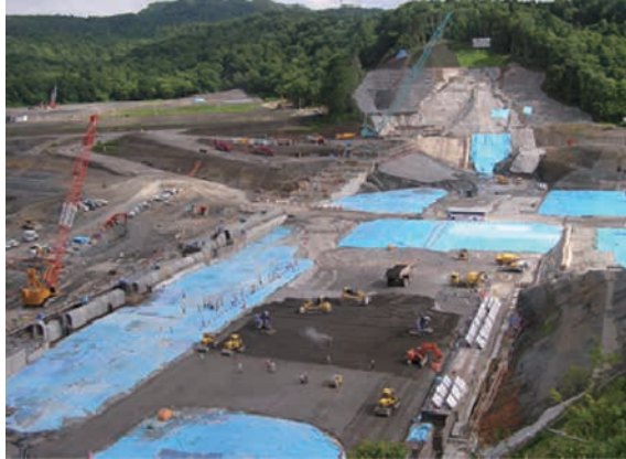
ダンプトラック等の汎用機械施工
