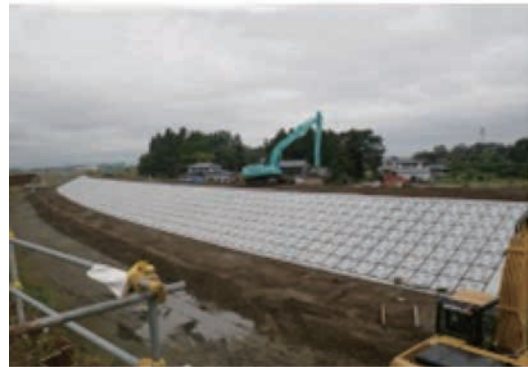
堤防復旧盛土状況（盛土＋護岸設置）
