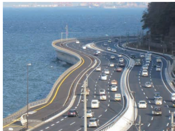
完成後の全景
