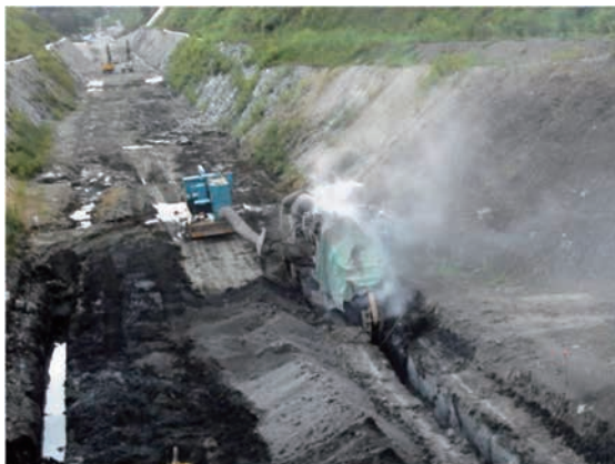
発破併用トレンチャー工法
