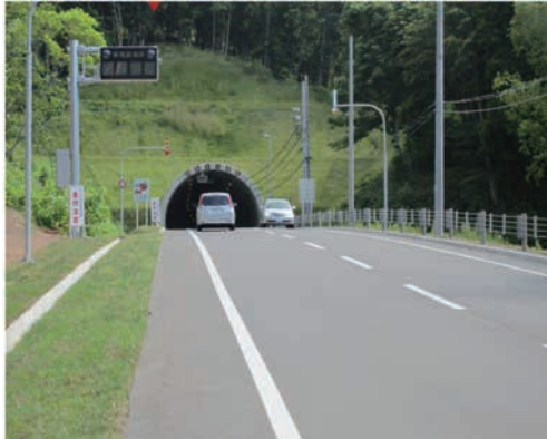
完成状況：余市町側
