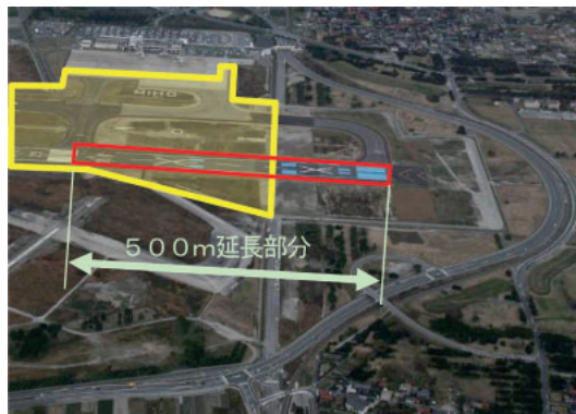
完成した滑走路500m延長部分
